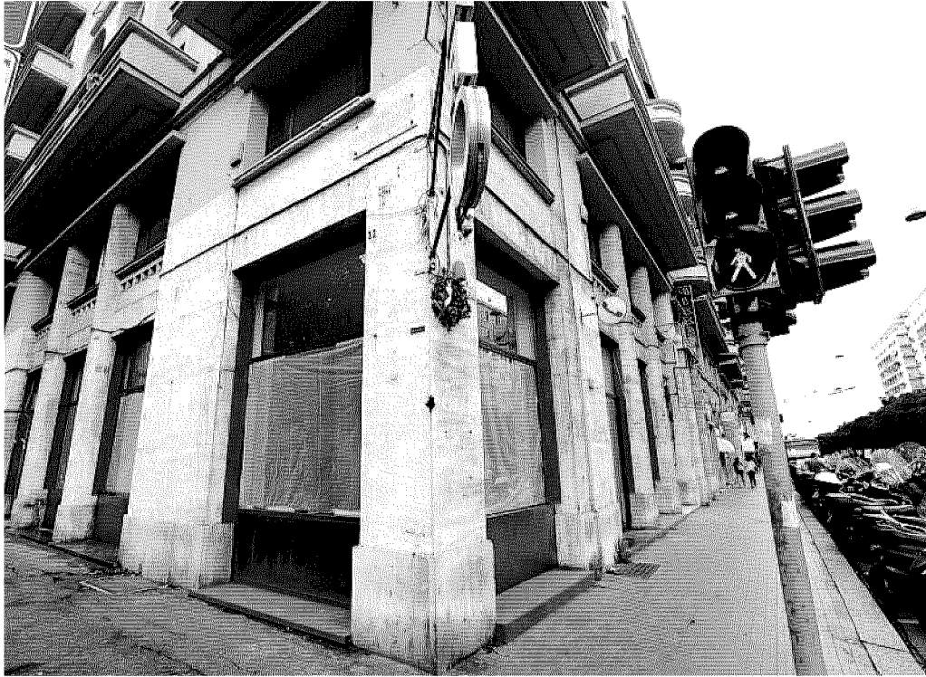
I locali di "Molinaro" chiusi all'angolo di via Cecchi (foto Bussalino)
